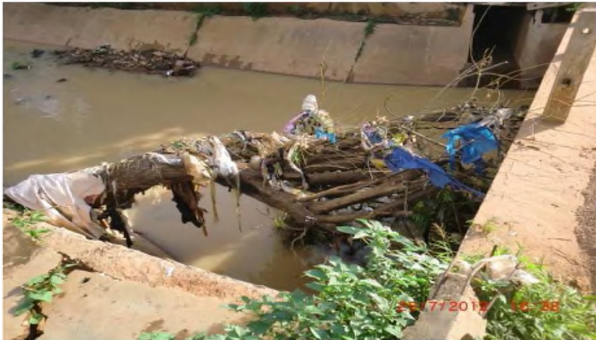
Figure7 : Phénomènes d’embâcles observés à PASPANGA dans le canal du centre (Cliché BANI Samari Saïdou)
