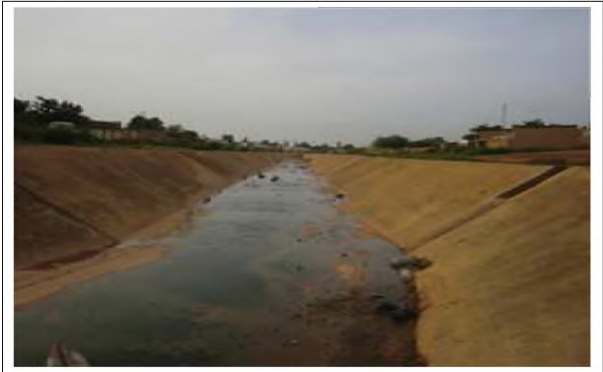
Figure5: capacité d'infiltration de l'eau limitée par le bétonnage du fond des marigots (Cliché BANI SAMARI Saïdou)
